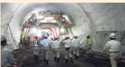
1日に6m進む小道木トンネル
