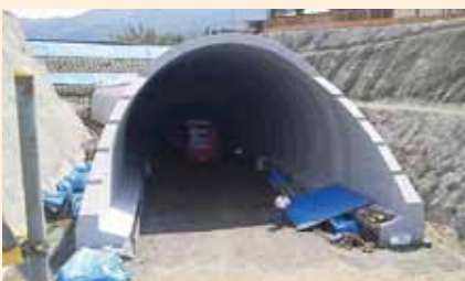
新しい工法のトンネル工事
