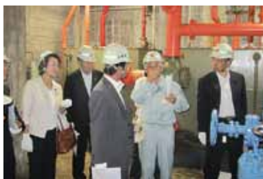
発電所の事故現場
